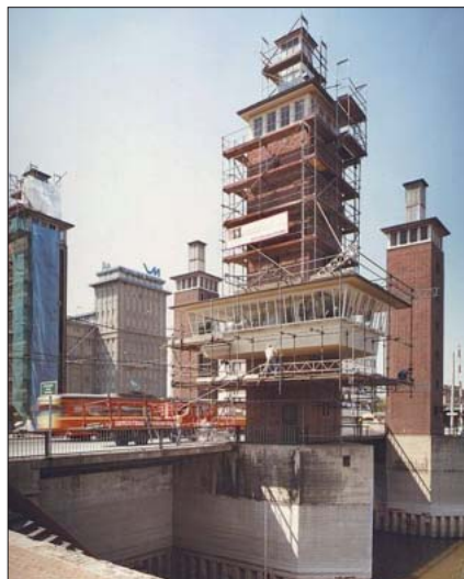
Korrosionsschutz und Betoninstandsetzung war nötig an einem bekannten Brückenkomplex im Ruhrgebiet – der Duisburger Schwanentorbrücke. (Fotos: Schmitz GmbH)
