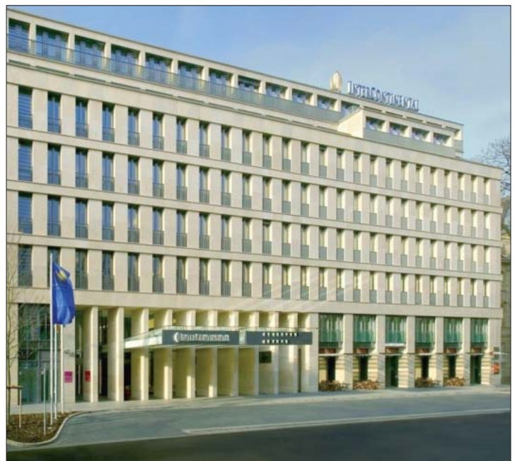
Auch die Malerarbeiten im Fünf-Sterne-Hotel InterContinental auf der Düsseldorfer Königsallee führte die Gerhard Schmitz GmbH durch. (Foto: InterContinental)
