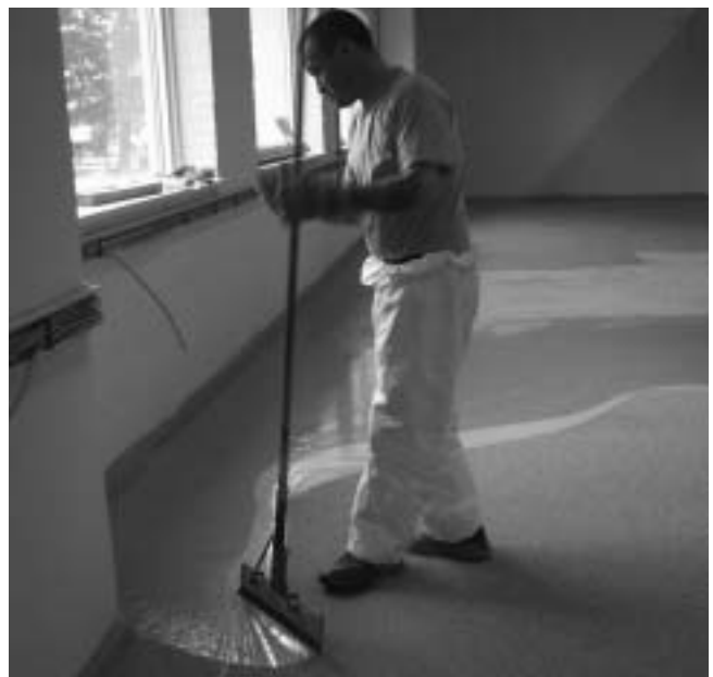
Verteilen von Harz mit einem langstieligen Gummiwischer
