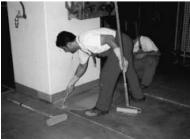
Bodenbeschichtung mit Epoxidharz
